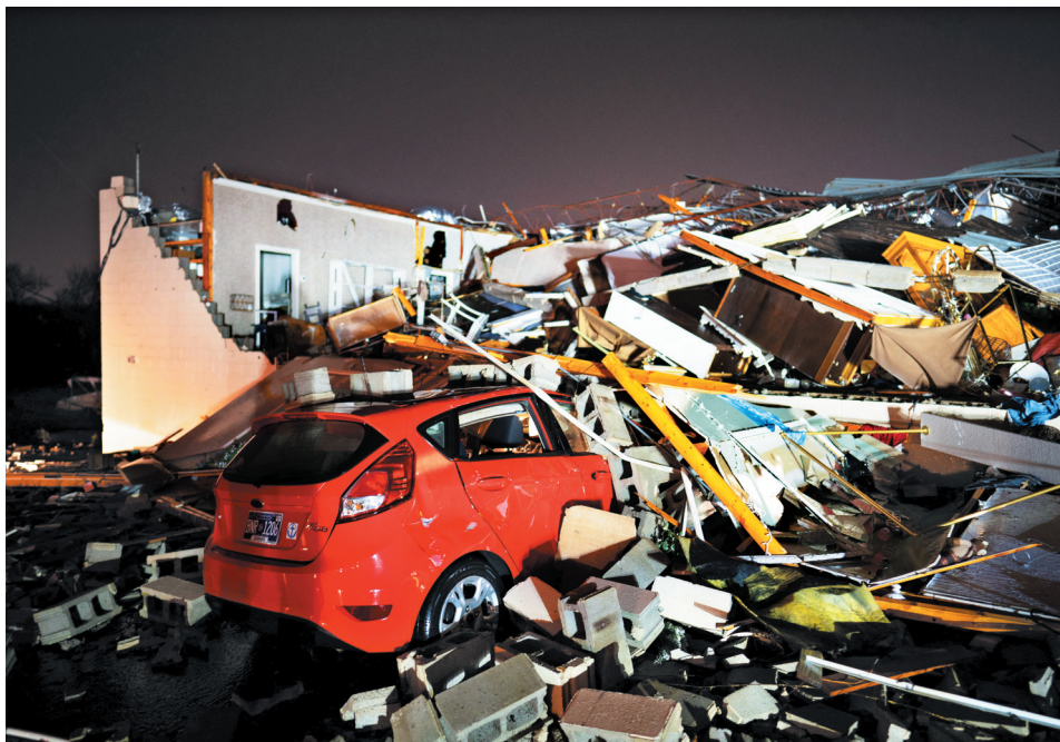
这是12月9日在美国田纳西州拍摄的遭龙卷风袭击受损的建筑和车辆。新华社/路透
