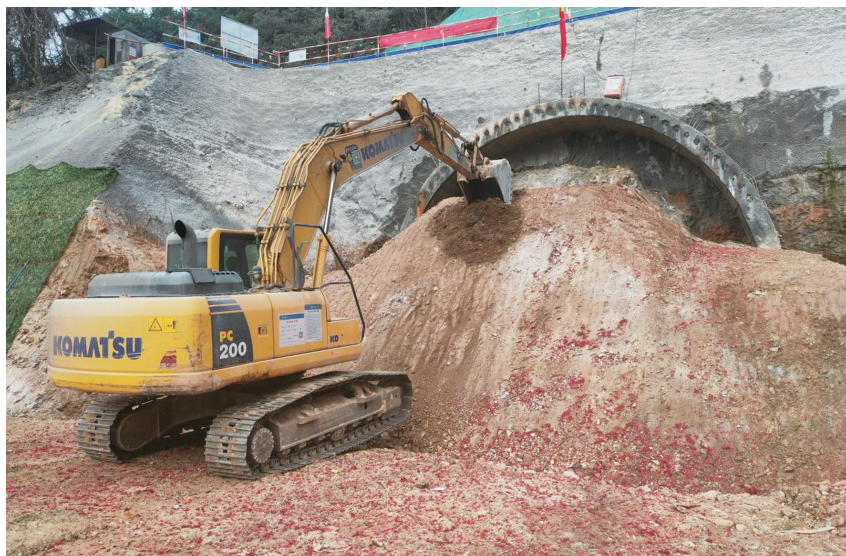
施工现场。(通讯员供图)
