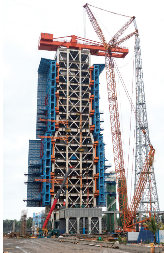
海南国际商业航天发射中心83米高的1号工位发射勤务塔封顶
