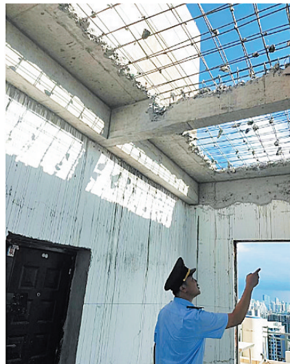
执法人员对新改建建筑进行拆除。
