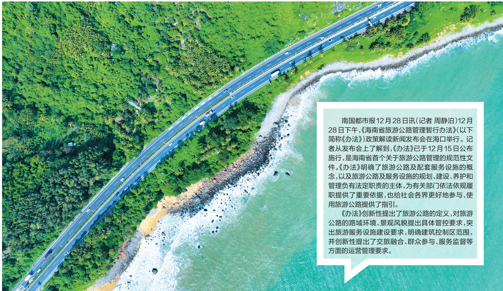
环岛旅游公路陵水段。(海报集团全媒体中心记者 王程龙摄)
