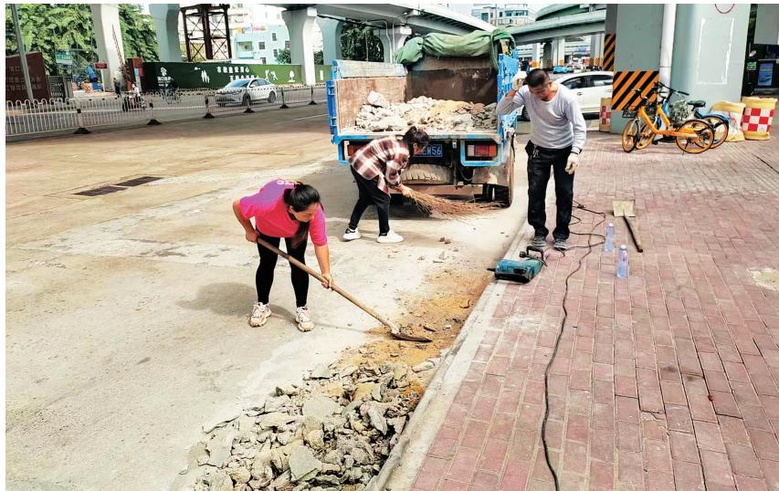
辖区城管组织人员对违建小斜坡进行拆除。
