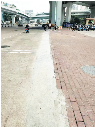
马路牙上加建的10米长水泥斜坡。
