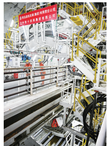
12月30日，建设者在胶州湾第二隧道工程南线主线隧道盾构掘进现场作业。新华社记者 李紫恒 摄
