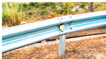
东方三家镇居侯村村道加装的护栏。
