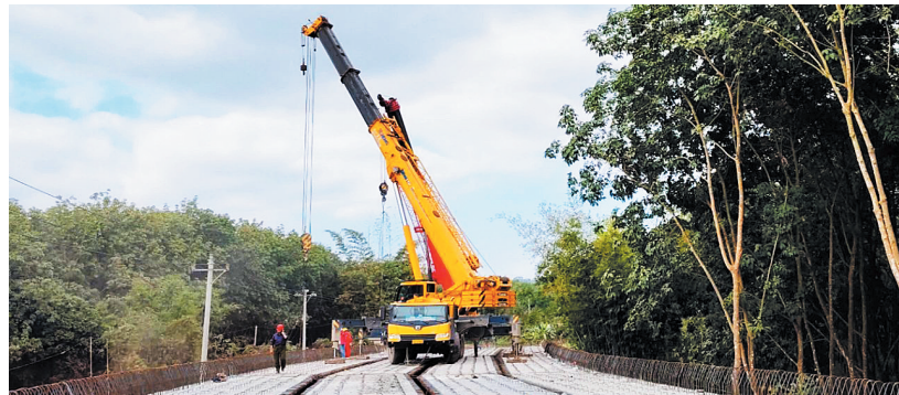
施工现场。(通讯员供图)
