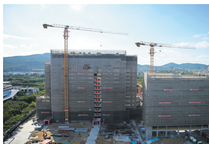
三亚市妇幼保健院二期项目现场。
