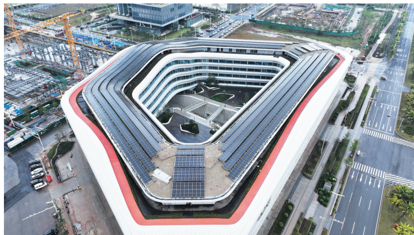
海口江东新区江东发展大厦屋面放置的5500平方米的光伏板。记者 郑光平 摄
