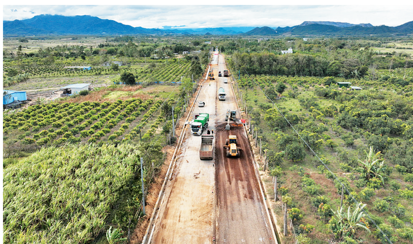
环热带雨林国家公园旅游公路TJLM06标段(七叉镇段)施工现场
