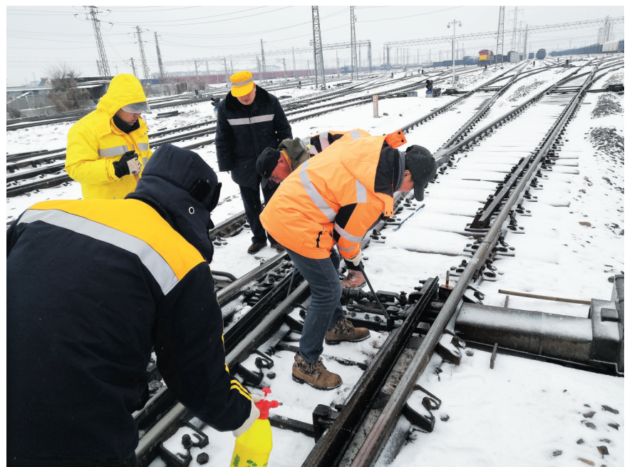
2月21日,中国铁路上海局集团有限公司合肥电务段职工在阜阳北三场编尾场开展扫雪除冰工作。 新华社发
