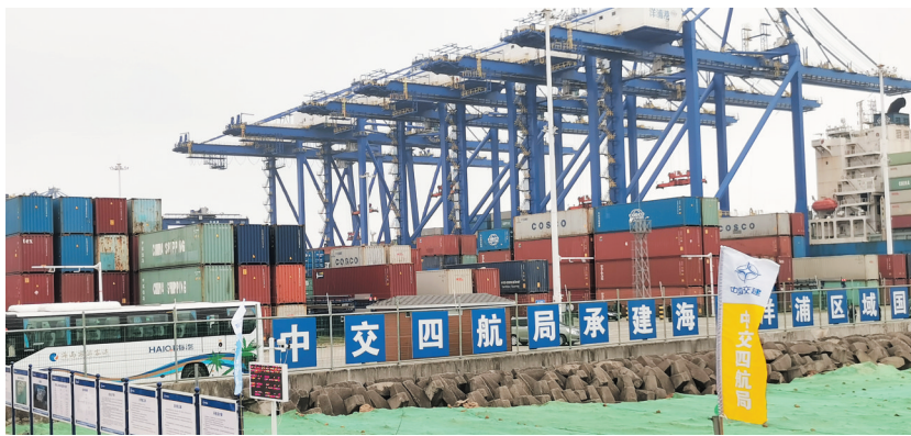
项目施工现场。
