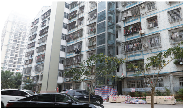
海口市美兰区和邦路9号加装的电梯。记者 郑光平 摄
