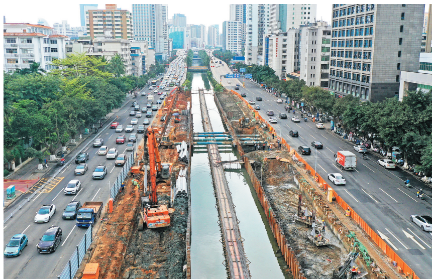
海口龙昆沟下游段综合整治工程现场一片繁忙。记者 汪承贤 摄
