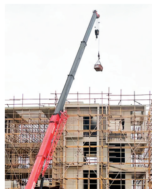
项目工地正在施工
