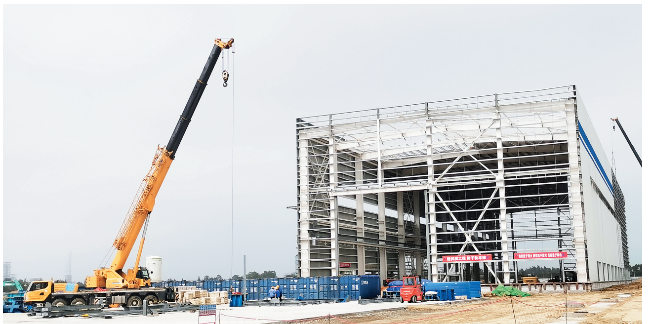
洋浦海上风电产业园项目施工现场。(记者 梁振文 摄)
