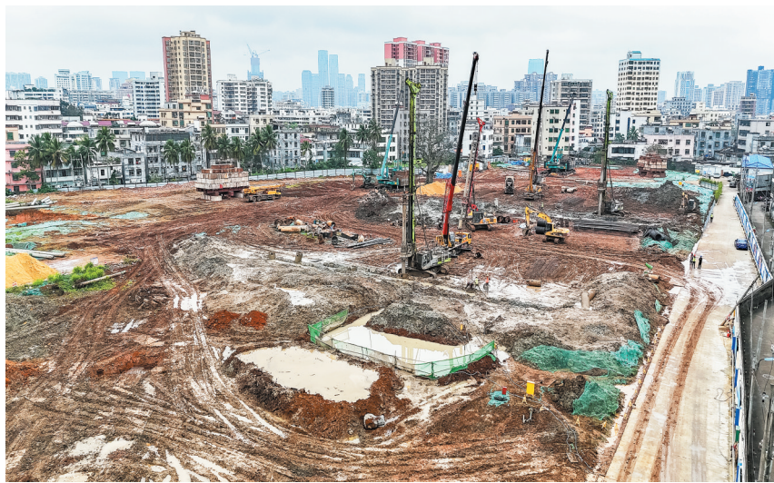
海口琼山区桂林片区(二期)城市更新项目施工现场。
