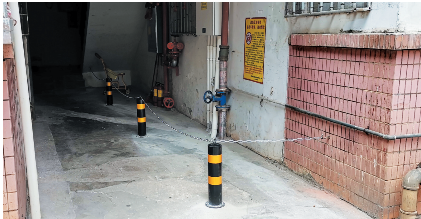
海口市秀英区爱华小区物业在楼道内安装的阻隔设施。
