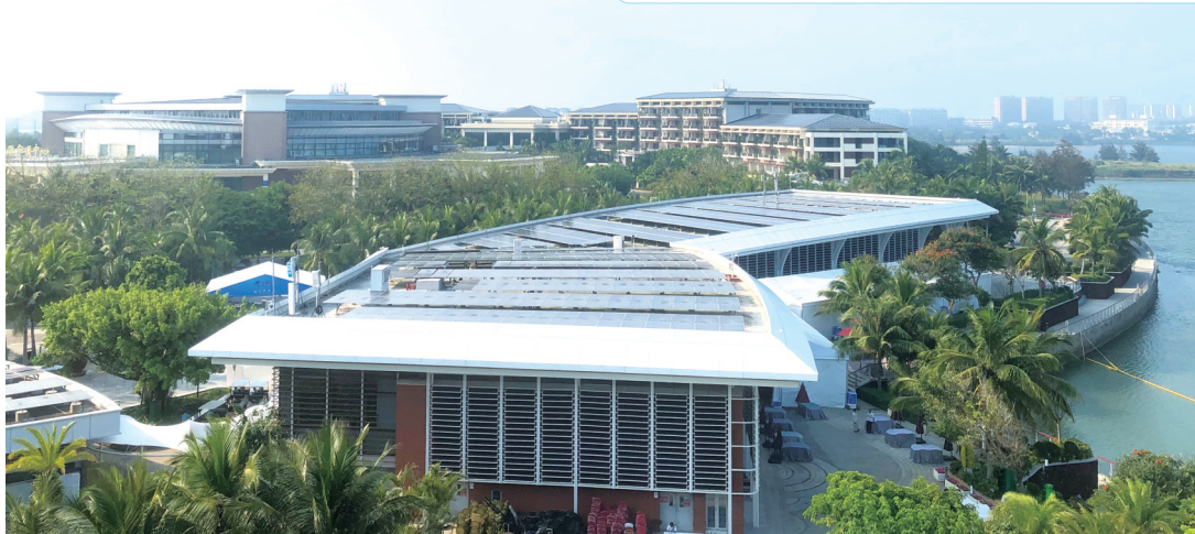
新闻中心屋顶的光伏板。
