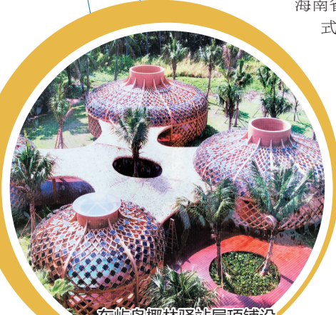
东屿岛椰林驿站屋顶铺设光伏发电板。(记者 苏桂除 摄)
