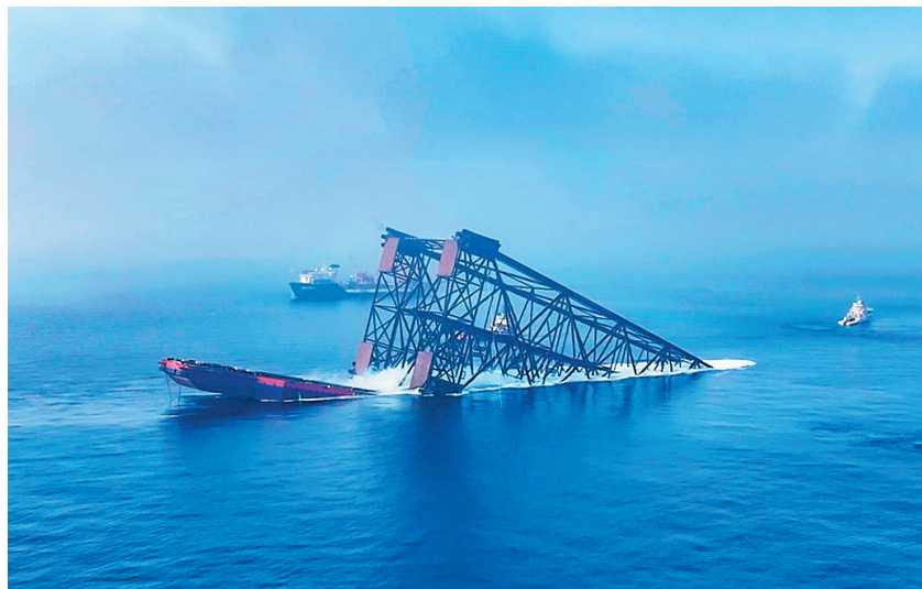
亚洲第一深水导管架“海基二号”滑移下水。(来源:人民日报客户端)
