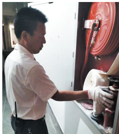
小区物业人员在检查消防设施。
