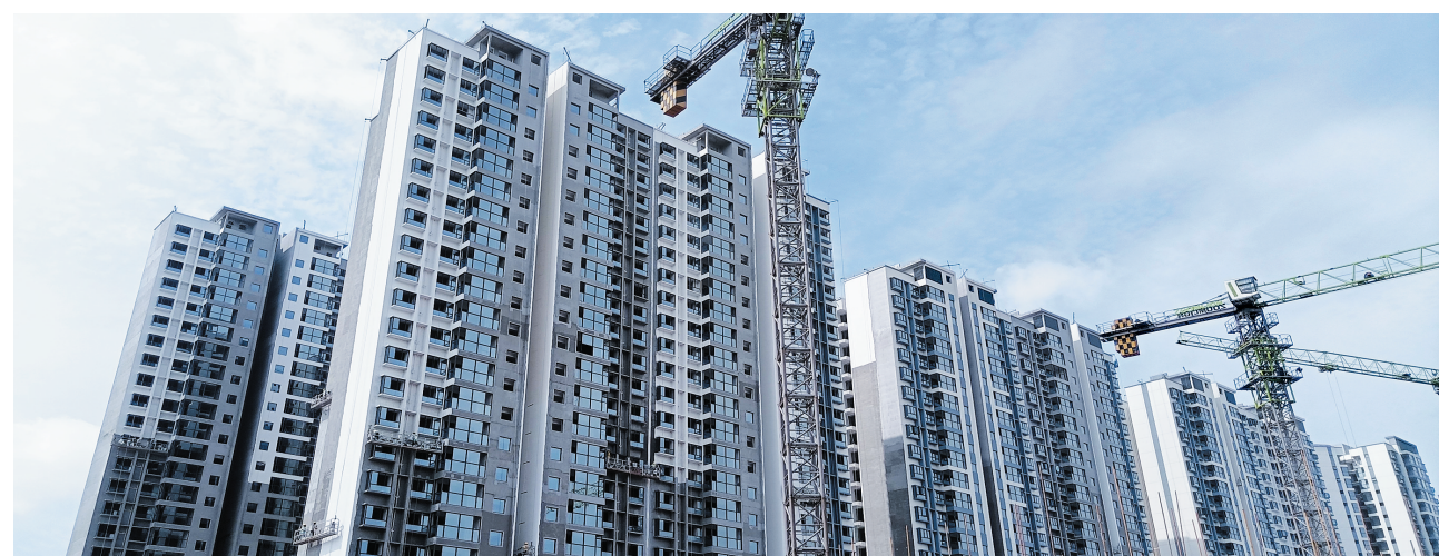
新高安居房项目西区1期已进入精装修阶段
