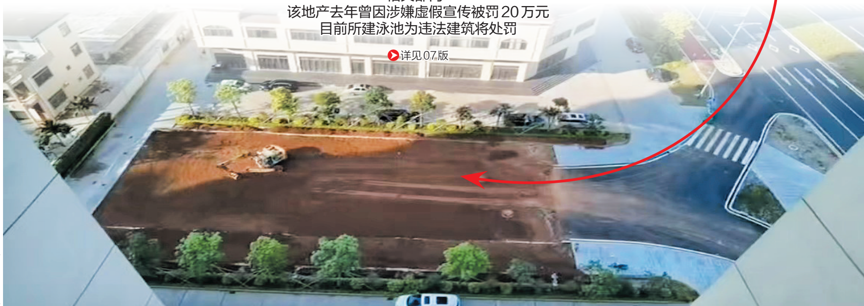
泳池回填施工现场(视频截图)
