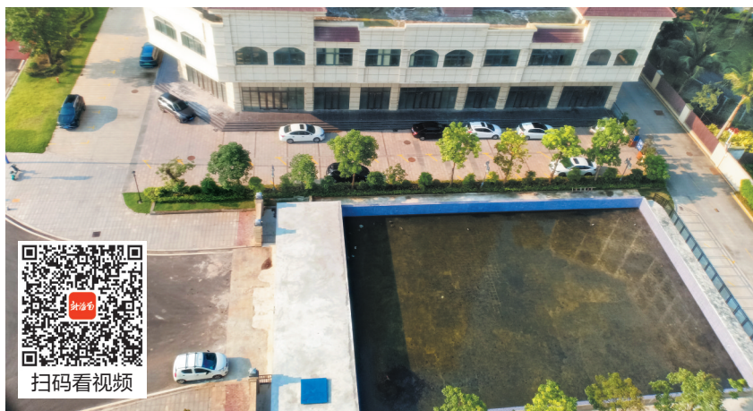
鸿信金海园的1、2号楼间的泳池现状。
