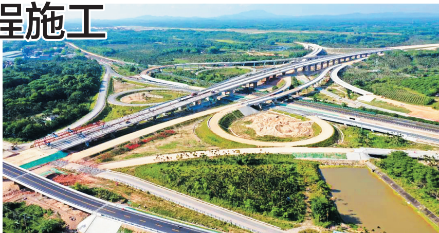
正在建设中的博鳌互通。(省交建局供图)
