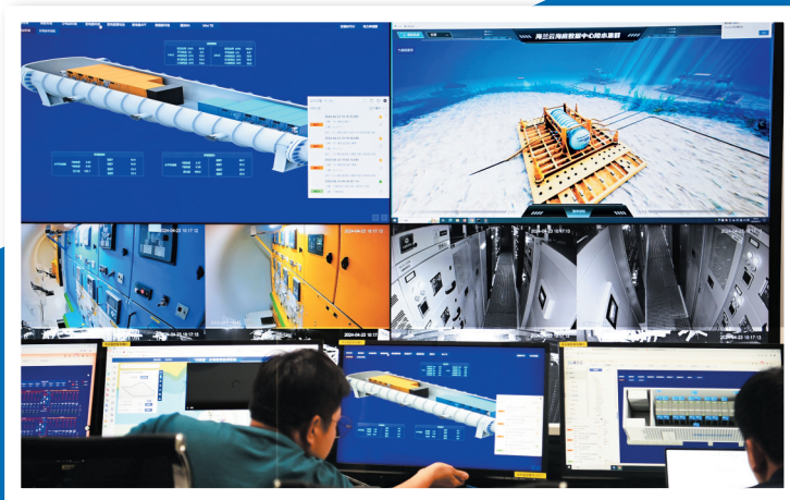
在海底数据中心项目岸站的总控室，技术人员通过屏幕关注着“海底数据舱”在水下的状态。记者 沙晓峰 摄
