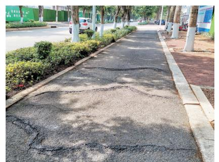
非机动车道路面被树根撑破。
