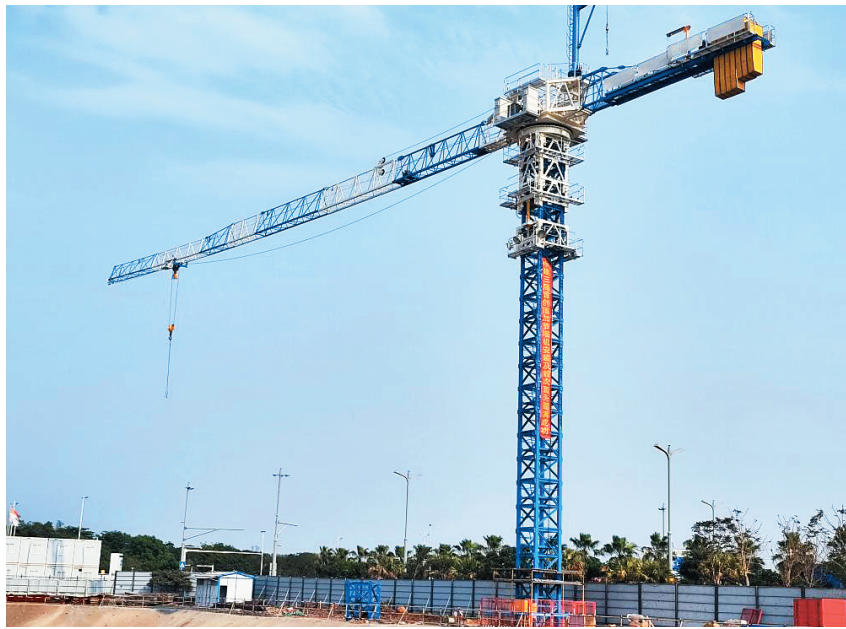
图为国内首批顶加节自升降式塔机正在作业。(资料图片)
