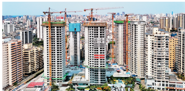
项目正在建设中。
