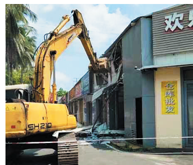
现场拆除作业。(海口市龙华区综合行政执法局供图)
