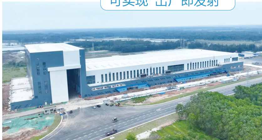
建设中的火箭装配厂房。
