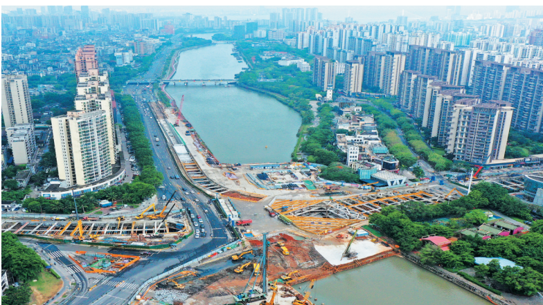
航拍海口白龙路下穿通道工程现场。
