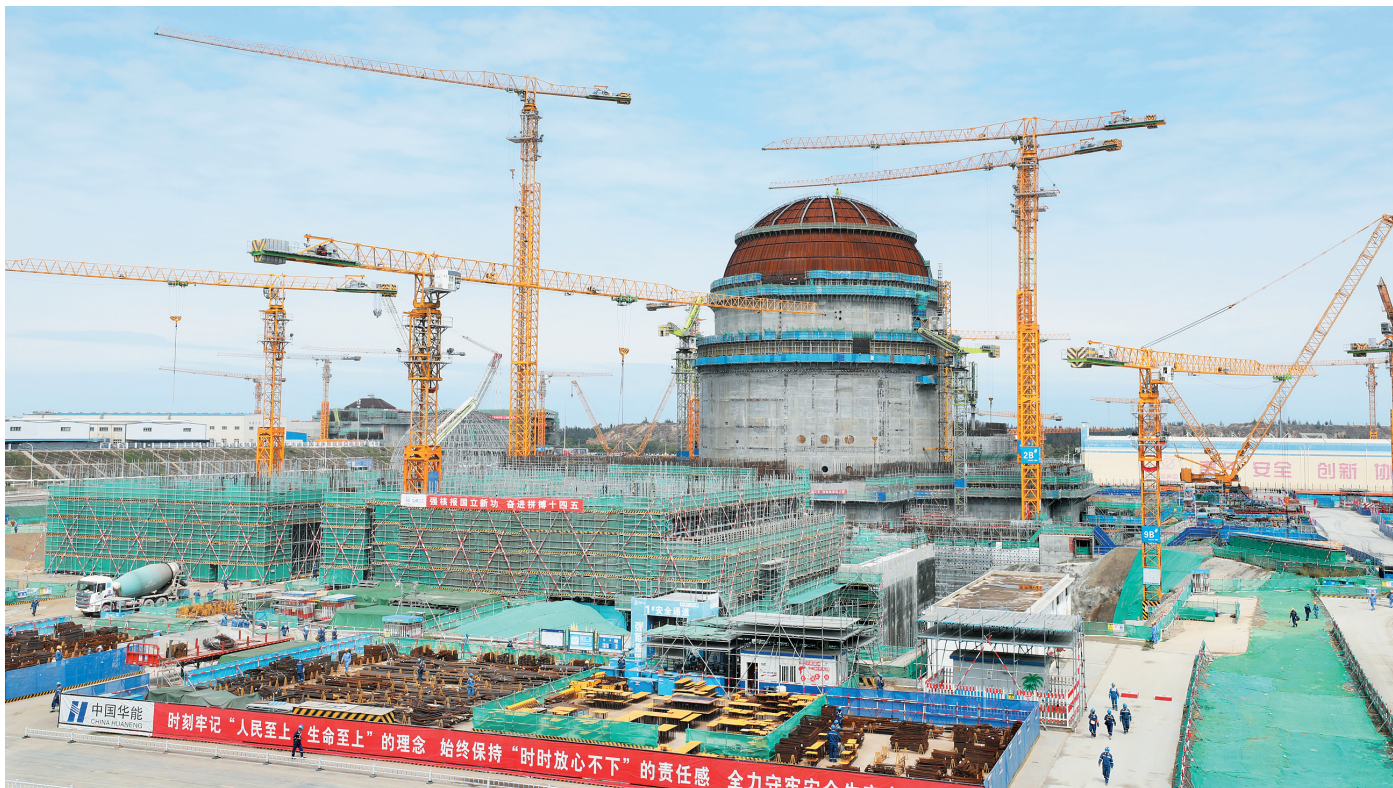
华能海南昌江核电二期工程项目施工现场。记者 郑光平 摄
