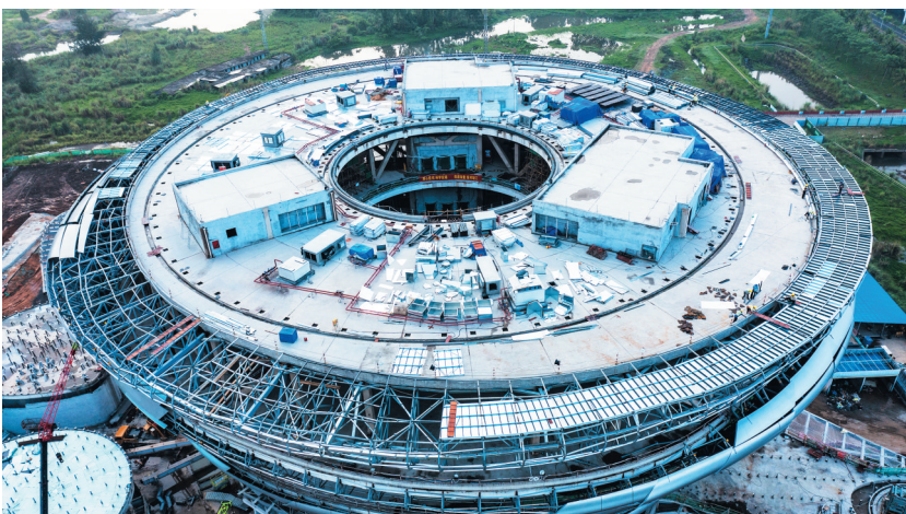
海南科技馆项目工人忙碌施工。
