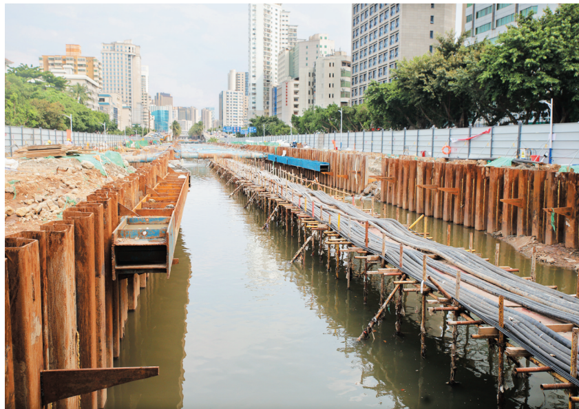
海口龙昆北路(龙昆沟项目段)施工现场。记者 王威 摄
