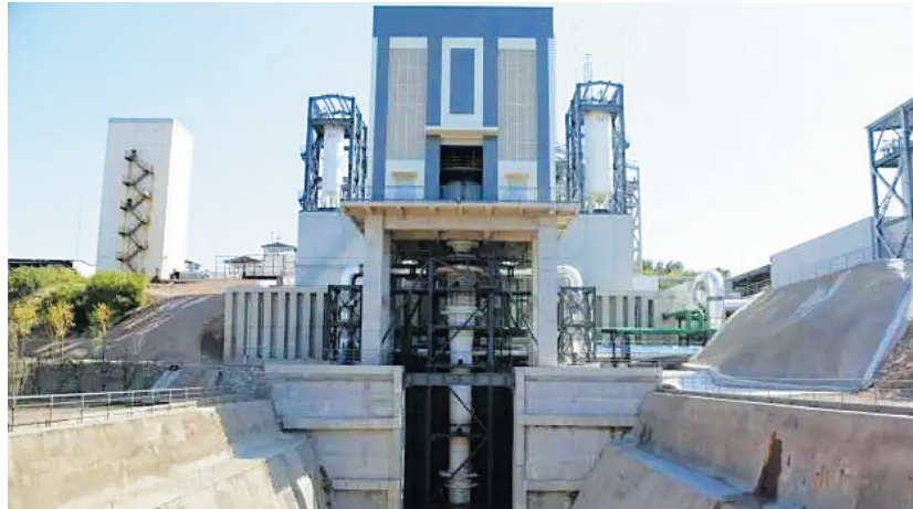
我国首个液体火箭发动机垂直高空模拟试验台。(据新华网)
