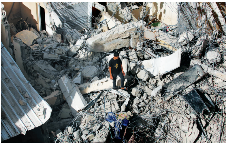
5月23日，在约旦河西岸城市杰宁，一名男子查看建筑受损情况。 新华社发
