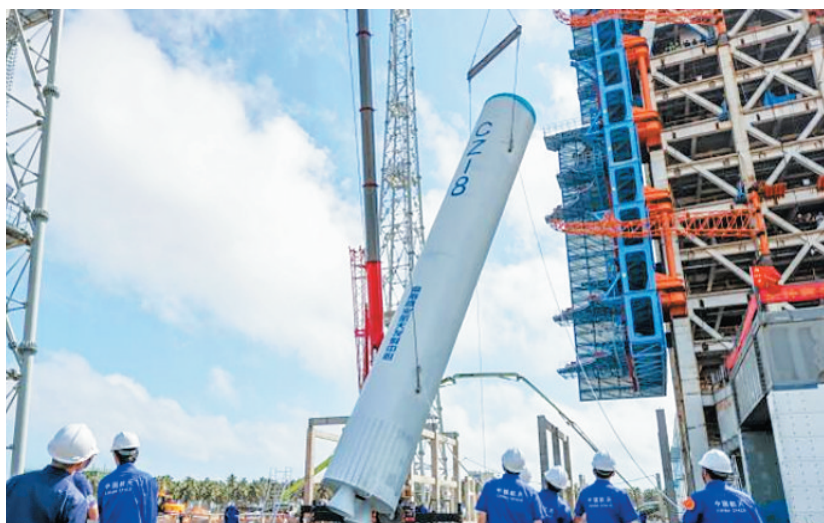
2024年2月1日,海南国际商业航天发射中心在一号发射工位启动模拟箭吊装训练。(资料图)
