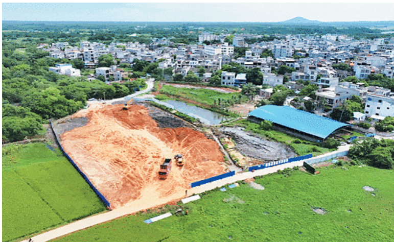
桄榔庵遗址项目建设现场。
