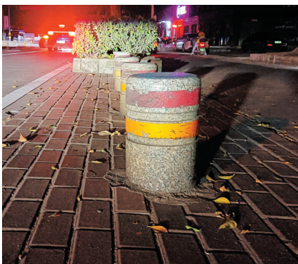
金垦路的挡车石贴反光条,夜间起到提示作用。
