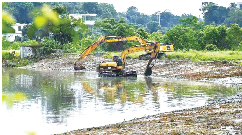
道孟河红丰村段正在开展河道内侧坡岸的清理工作。(海口市生态环境局供图)
