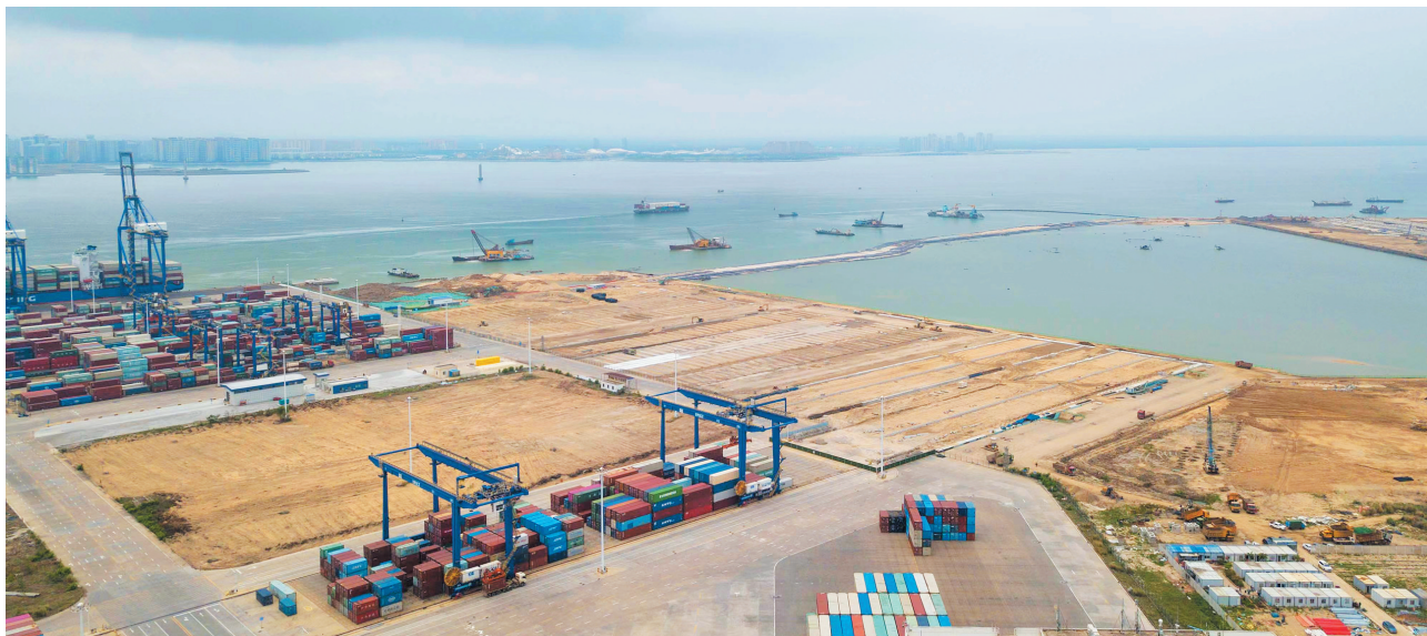
海南洋浦区域国际集装箱枢纽港扩建工程施工现场。(中交四航局供图)
