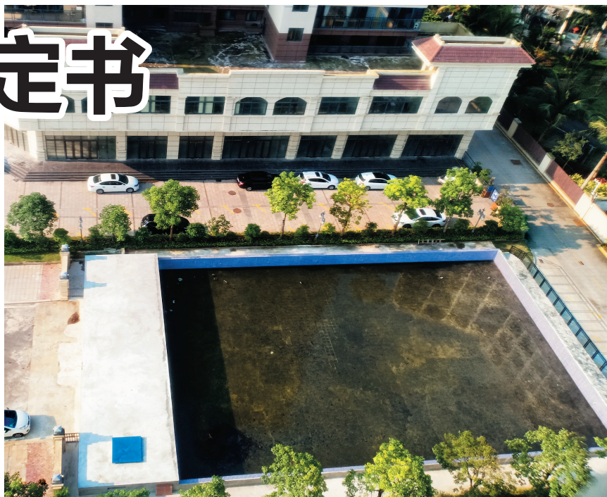
鸿信金海园违建泳池仍未整改拆除。
