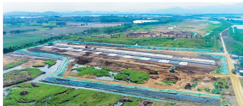
感恩河水系连通及水美乡村项目建设现场。(东方市融媒体中心供图)
