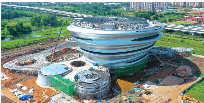
海南科技馆项目渐渐露出了真容。记者 汪承贤 摄
