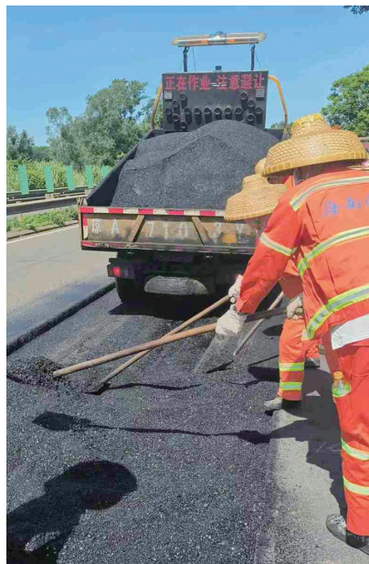
养护工人正在修复路面。
