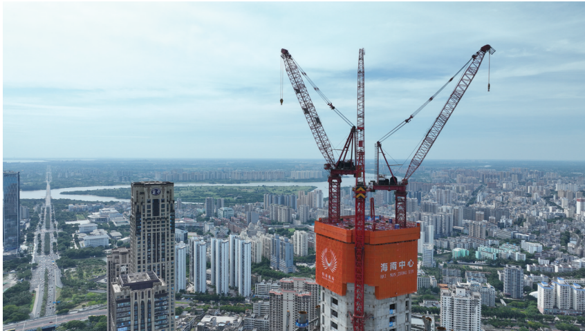
海南中心项目通过空中造楼机给工人安全舒适的工作环境。记者 郑光平 摄
